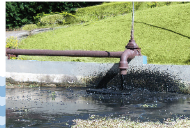
Estação de tratamento de esgoto
