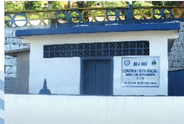
Elevatória de esgoto
