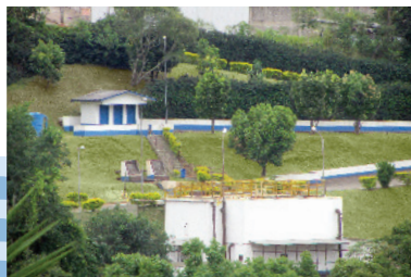
Estação de tratamento de esgoto
