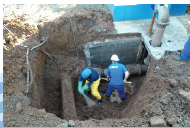
Manutenção de adutora de recalque
