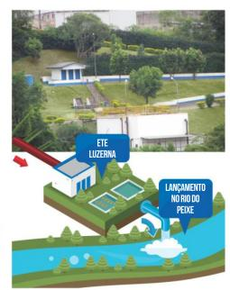
O processo de tratamento de esgoto adotado nas ETEs do Simae é biológico, ou seja, através da ação de microrganismos. Nas ETEs esses microrganismos consomem a matéria orgânica presente no esgoto, purificando-o e possibilitando a sua devolução ao rio, sem poluí-lo.
