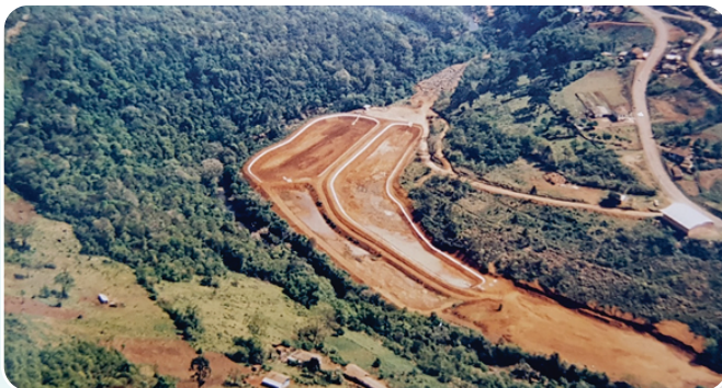
Foto do acervo do Simae, tirada em 1991, antes da inauguração da ETE Herval d'Oeste.
